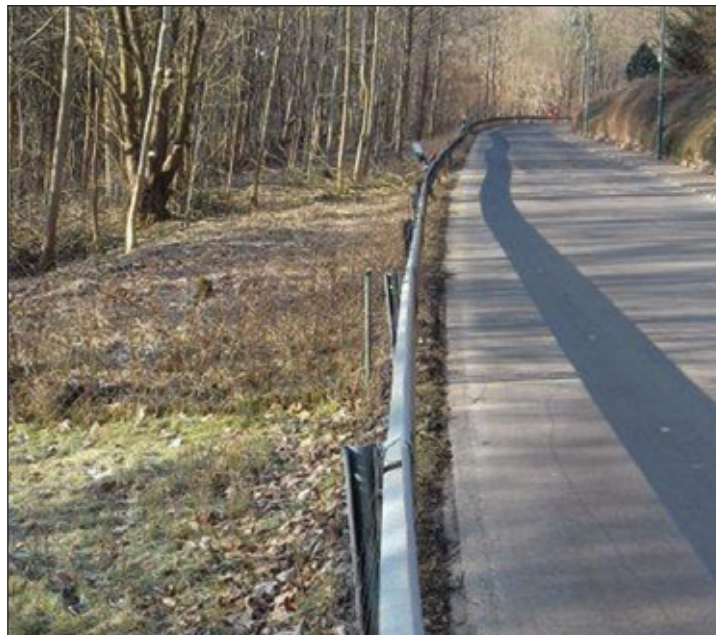
Hauptstraße nach Freischneidarbeiten
