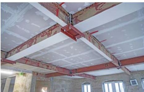
Diese eher untypischen Stahlträger wurden bei den Abbrucharbeiten in dem Kasernengebäude entdeckt. Sie tragen die Decke des Dachgeschosses und das Dach.
